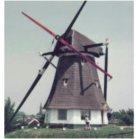
Het plaatsen van de eerste roeden bij de Akkerslootmolen in Rijpwetering in 1983. (Foto: Archief J. Straathof BV)
